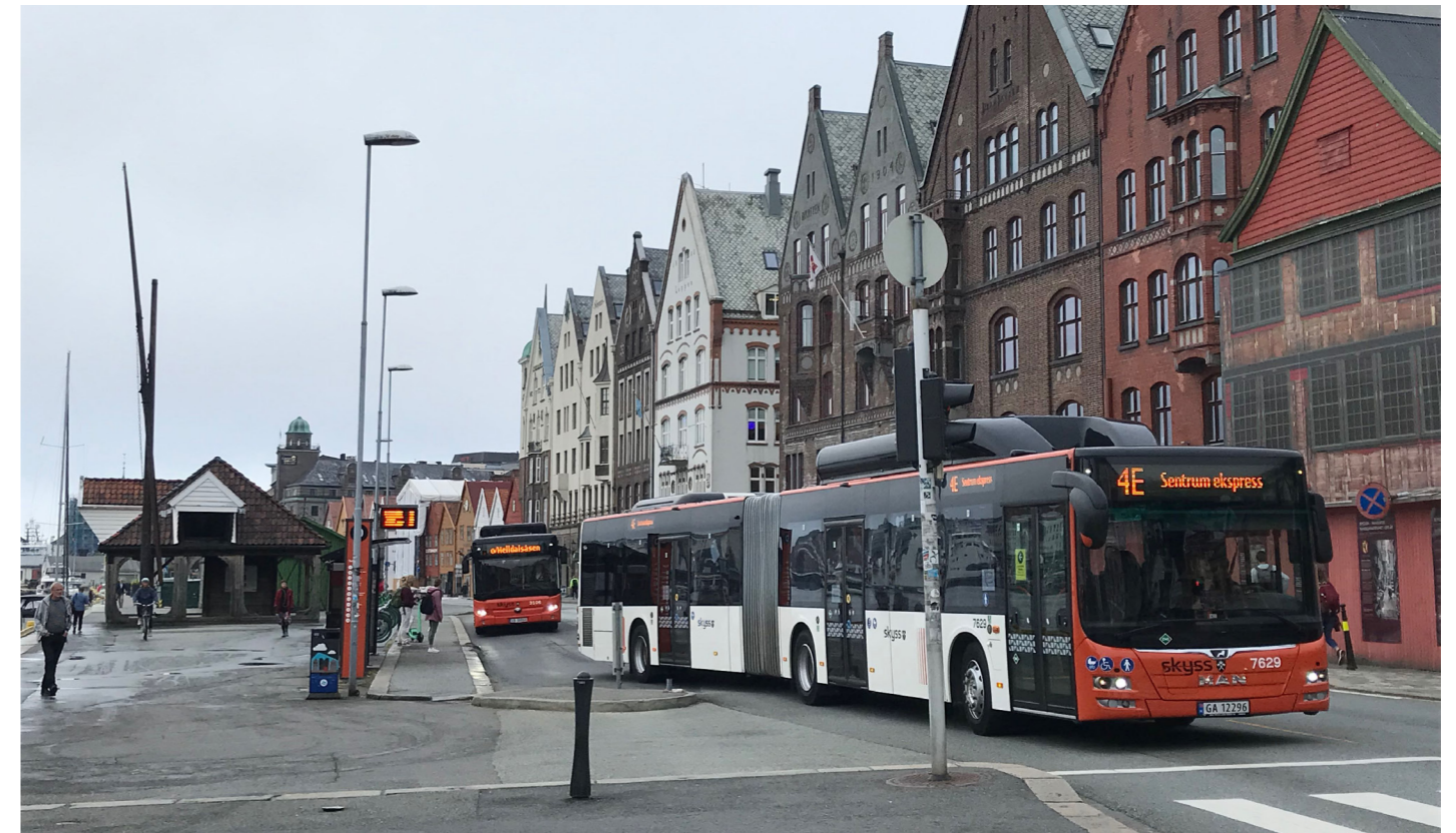
Dagens situasjon med veilysmaster
