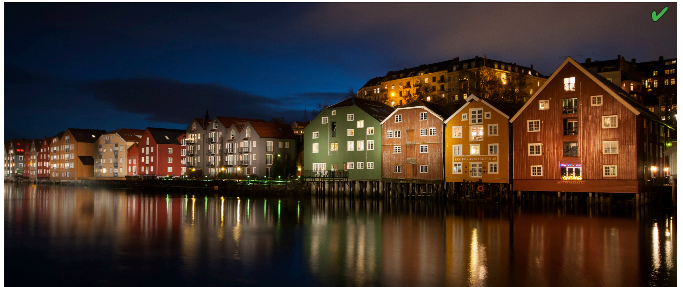
Prøvebelysning av Kjøpmansrekken i Trondheim hvor armaturer med 10 grader spredning lyser fra andre siden av elven.
